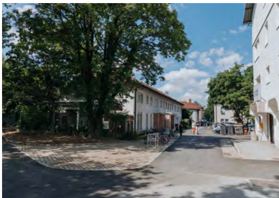
Asfalt so ohranili zgolj na delih, kjer je potreben za prometno pretočnost, ostale površine pa so tlakovali s travnimi rešetkami. Foto: Amadeja Smrekar
